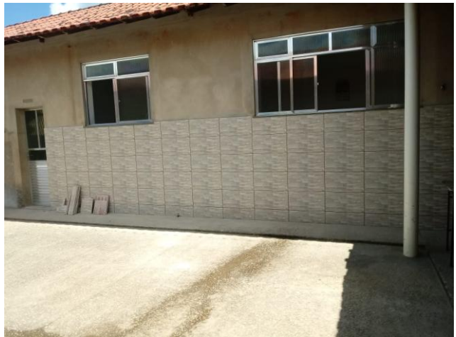
Ook de binnenplaats wordt betegeld
