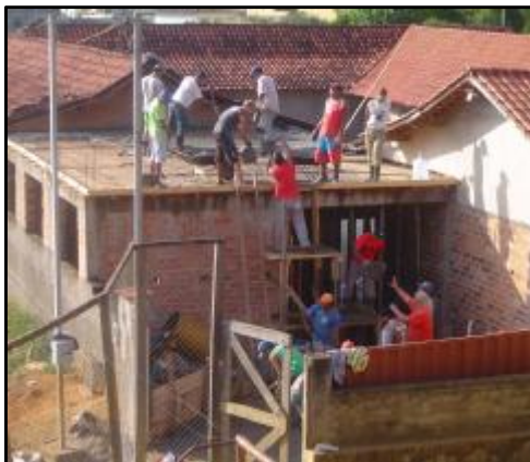
Een heleboel mannen helpen met het maken van het platte dak op de zaaltjes van de crèche.
