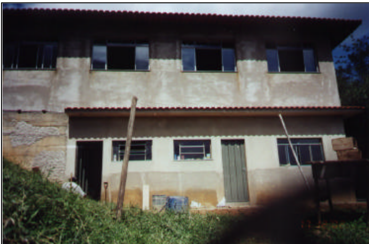
Een deel van de crèche met daar onder de woning van Fernando en Danielle.
